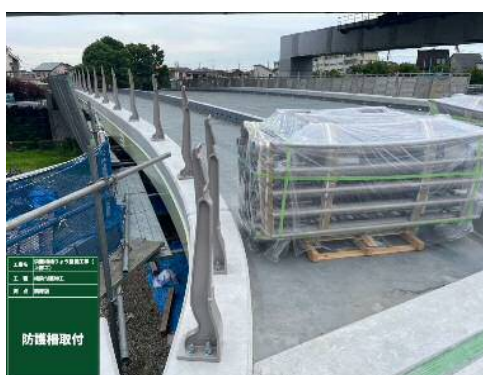
支柱を取り付けて柵を据付
