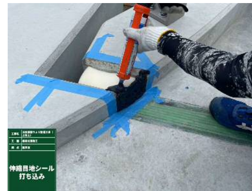
地覆目地(伸縮装置部)にシール打設
