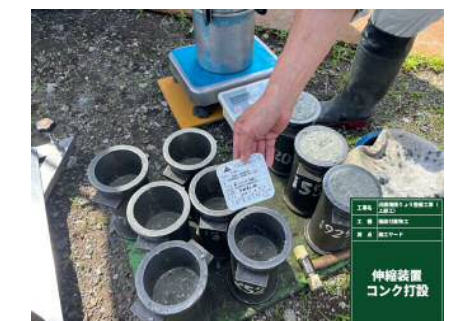
試験体抜き取り
