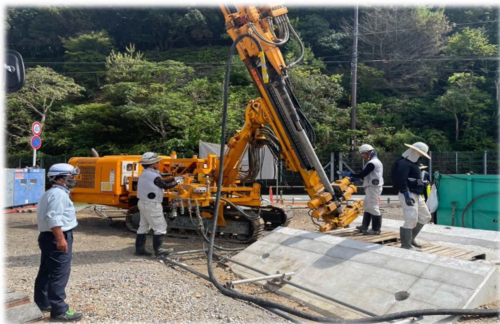
工事名 主要地方道伊勢磯部線(恵利原橋)橋梁耐震対策(上部工)工事 工種 グラウンドアンカー 測点 A1-L側(後方-道路側) グラウンドアンカー挿入
