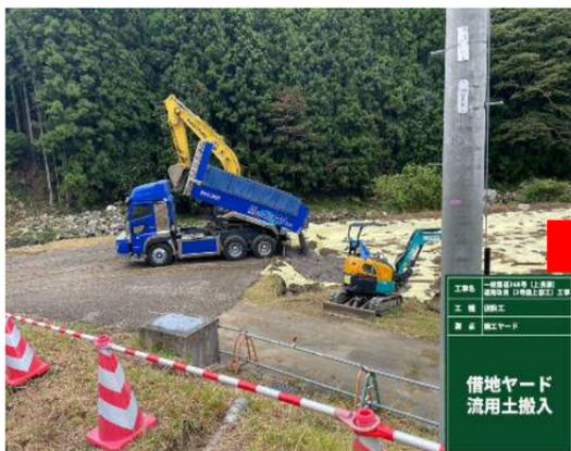
大型車両・重機を使っでの土砂を搬入し約30cm程度つつ締め
